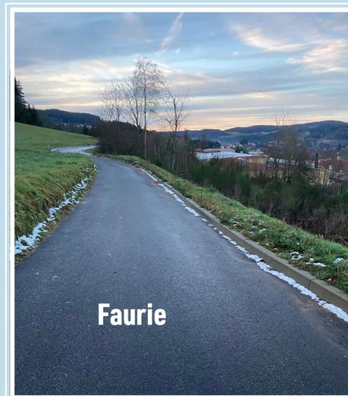
Le programme 2022 a permis de réaliser ces 3 secteurs. Un revêtement d'enrobé de 150kg/m<sup>2</sup> a été posé sur une distance de 800m pour un montant de 51 944,70 HT. Travaux réalisés par EUROVIA.
